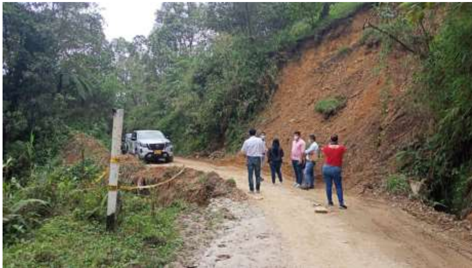
Imagen 6. Talud inestable caída de material- Ladera inestable caída de banca
